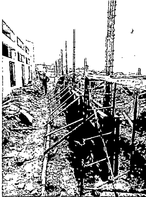
FOTO N° 05: Sobrecimiento de cerco perimétrico posterior al DPA.
