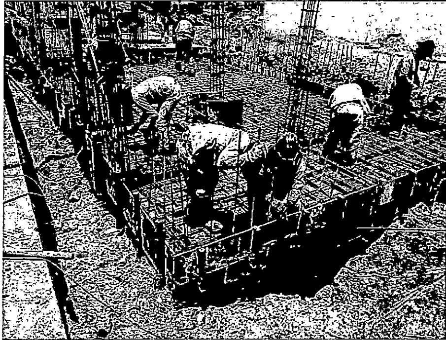
Foto N° 7.24: Encofrado, habilitado de acero para losa de techo – Cisterna de agua potable y salada
