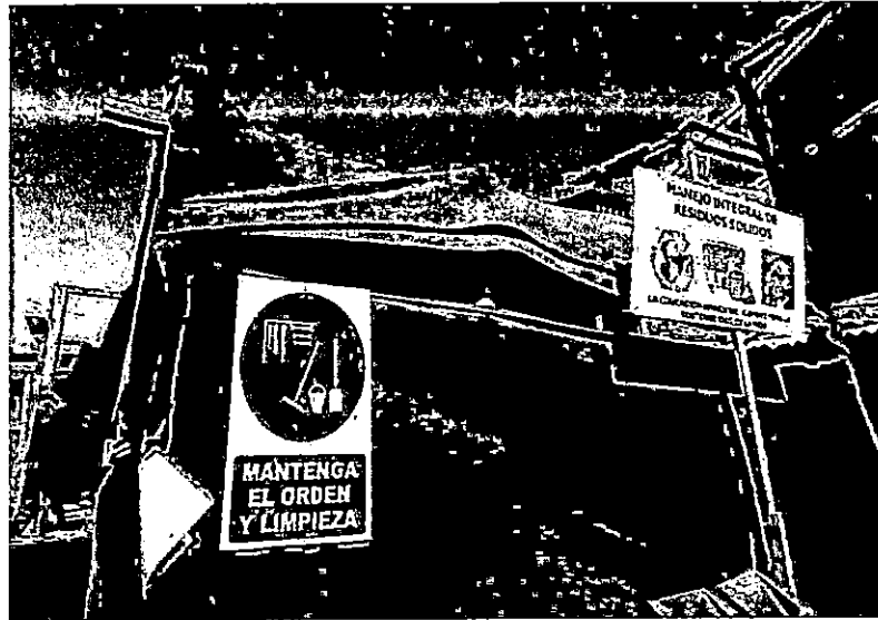
Figura N° 6.1.16.2 - Señalización ambiental dentro de la obra
