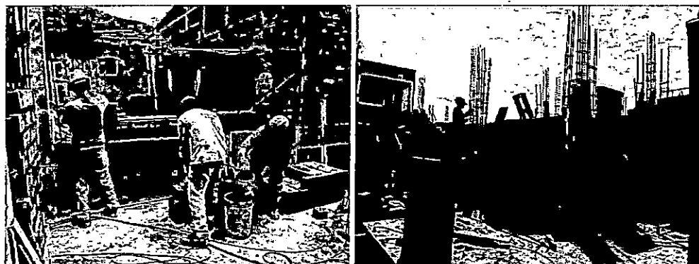
Foto N° 2.3.1.22: Construcción de muros de albañilería – Cuarto de bombas de la cisterna de agua potable y salada
