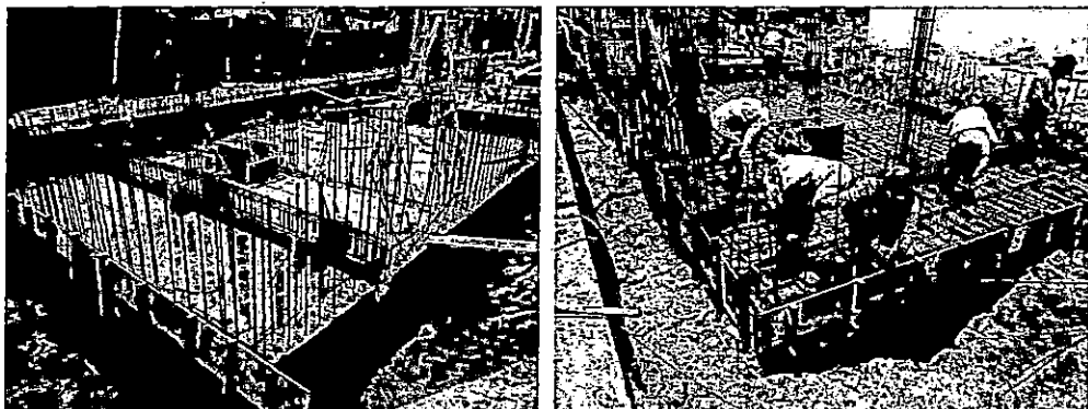
Foto N° 2.3.1.19: Encofrado, habilitado de acero para losa de techo – Cisterna de agua potable y salada
