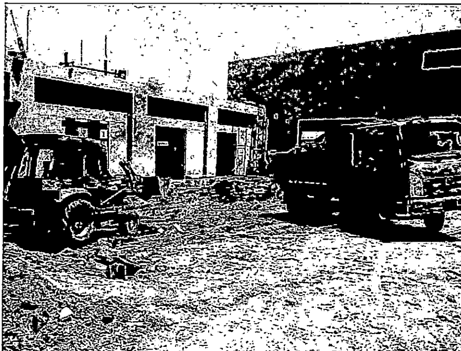
Foto N° 7.17: Trabajos de movimientos de tierras – Obras Exteriores
