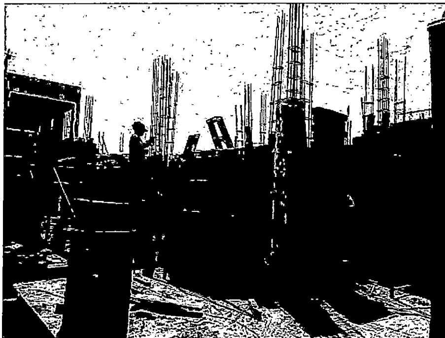
Foto N° 7.27: Construcción de muros de albañilería – Cuarto de bombas de la cisterna de agua potable y salada
