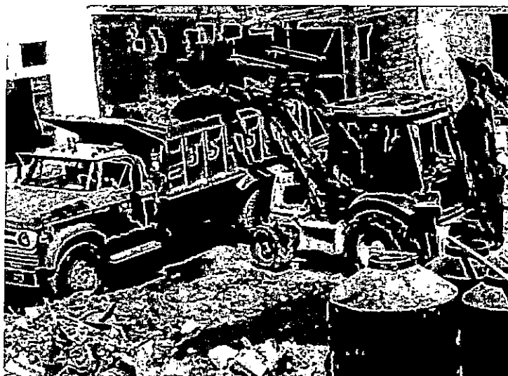
Figura N° 6.1.13.2 - Limpieza de los residuos almacenados, para luego ser evacuados en volquetes a las zonas de botadero.
