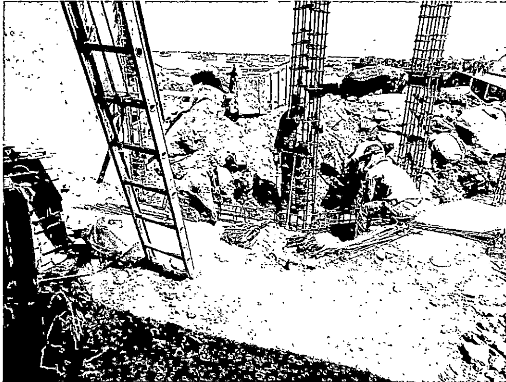
FOTO N° 07: Colocado de columnas del cerco perimétrico.
