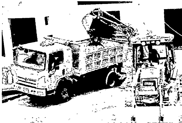
Foto 18: Limpieza de los residuos almacenados, para luego ser evacuados en volquetes a las zonas de botadero
