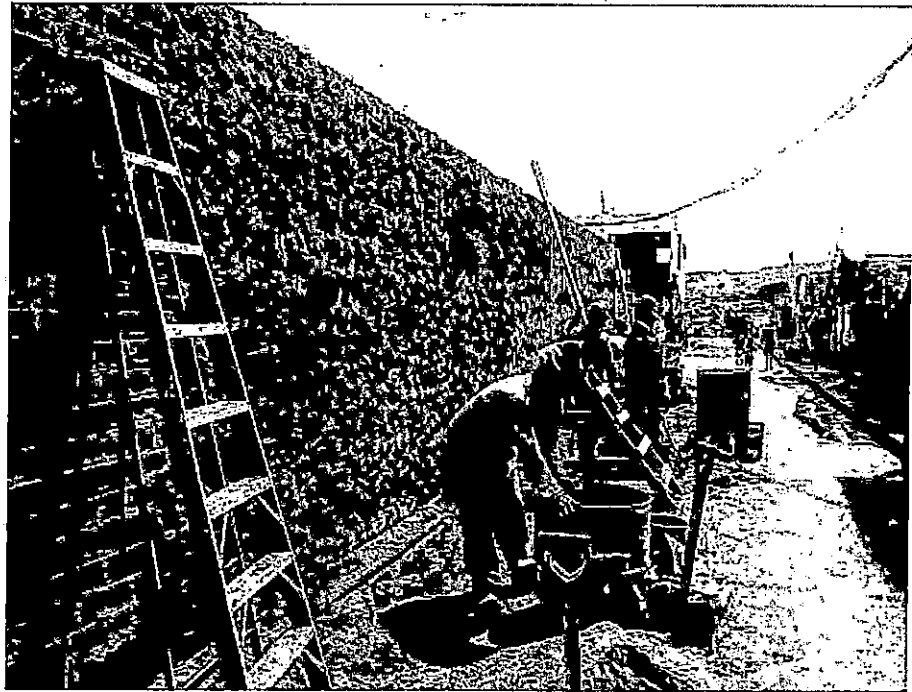
Foto N° 7.32: Tarrajeo de muros – Cerco Perimétrico
