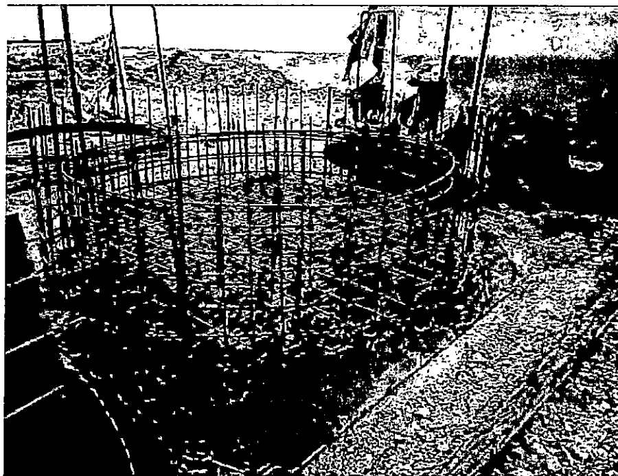
Foto N° 7.18: Cisterna de cámara de bombeo – Emisor Submarino
